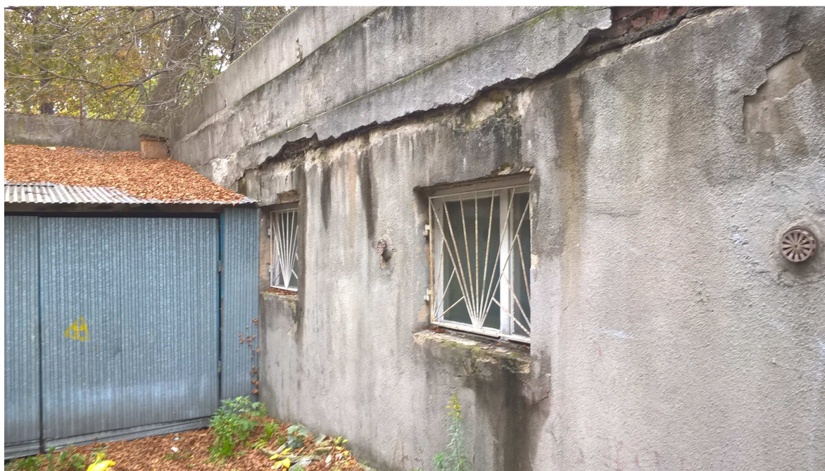
Odspojenia tynku
