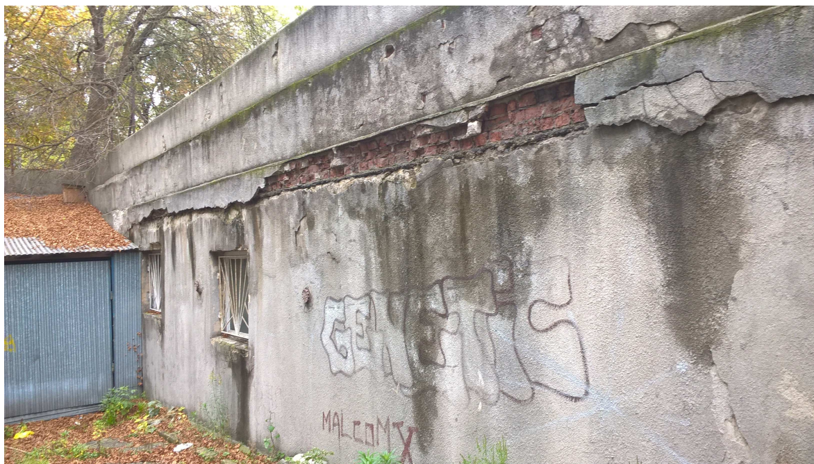
Odspojenia tynku
